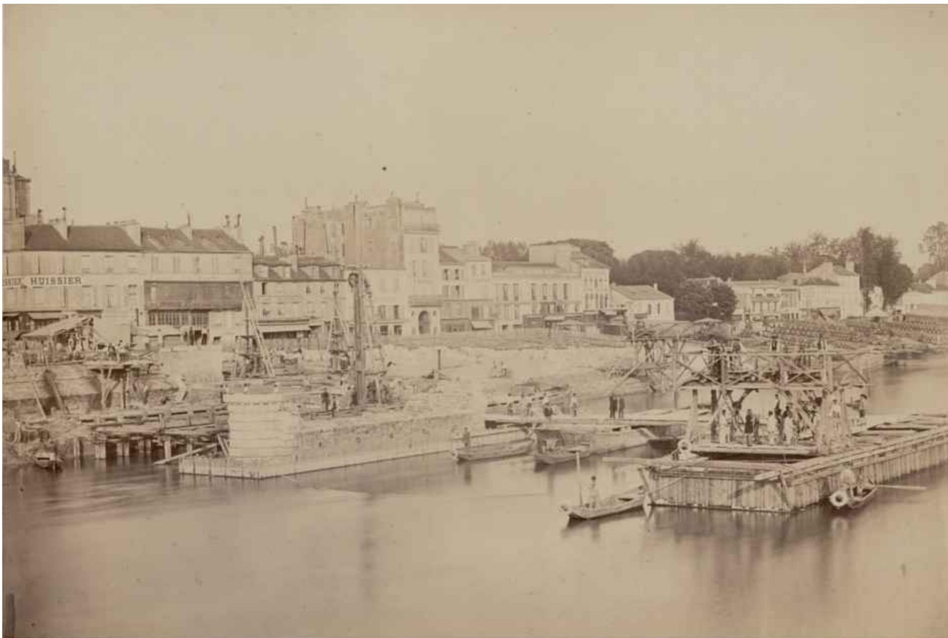
Fig. 5 : Auguste-Hippolyte Collard (1812-1893), *Pont de Bercy*. *Vue du chantier pendant le coulage du béton de la 3<sup>e</sup> pile*, 1863-1864. Épreuve sur papier albuminé, 28 x 42,5 cm. École nationale des ponts et chaussées, Paris
