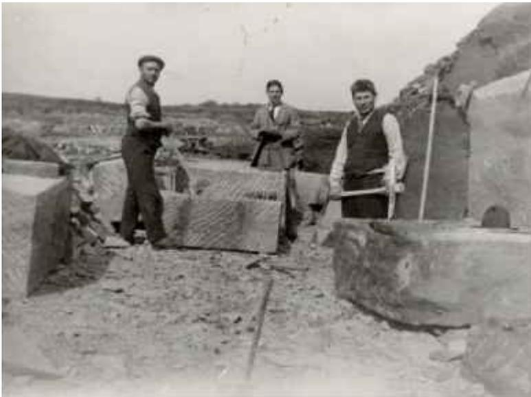
Fig. 23b : Façonnage des pierres brutes en blocs taillés. Collection Pierre Wies
