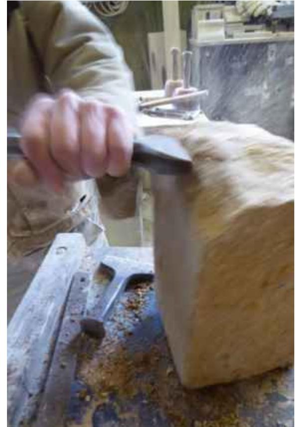
Fig. 21 : Préparation d'une surface plane par taille grossière avec la chasse, ciseau à lame épaisse, chassant sous les coups de la massette des fragments de roches sur la largeur de la lame. Peter Weinand, Carrières Feidt, Ernzen
