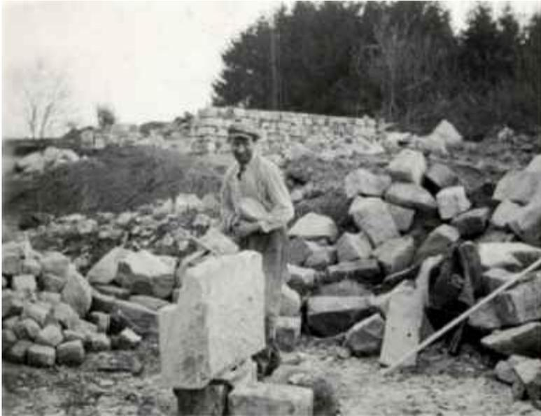
Fig. 23a : Le tailleur de pierre devant la pierre à laquelle il donnera des surfaces planes. Notez l'épure posée contre une pierre près de la veste de l'ouvrier. Collection Pierre Wies
